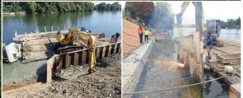
Travaux sur berge
