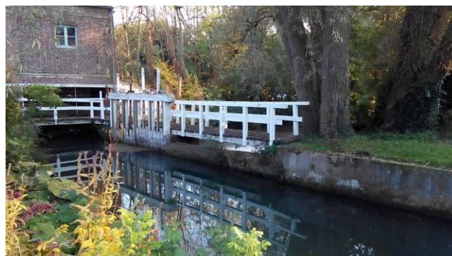
Photographie des ouvrages du moulin – Etat initial 2015
