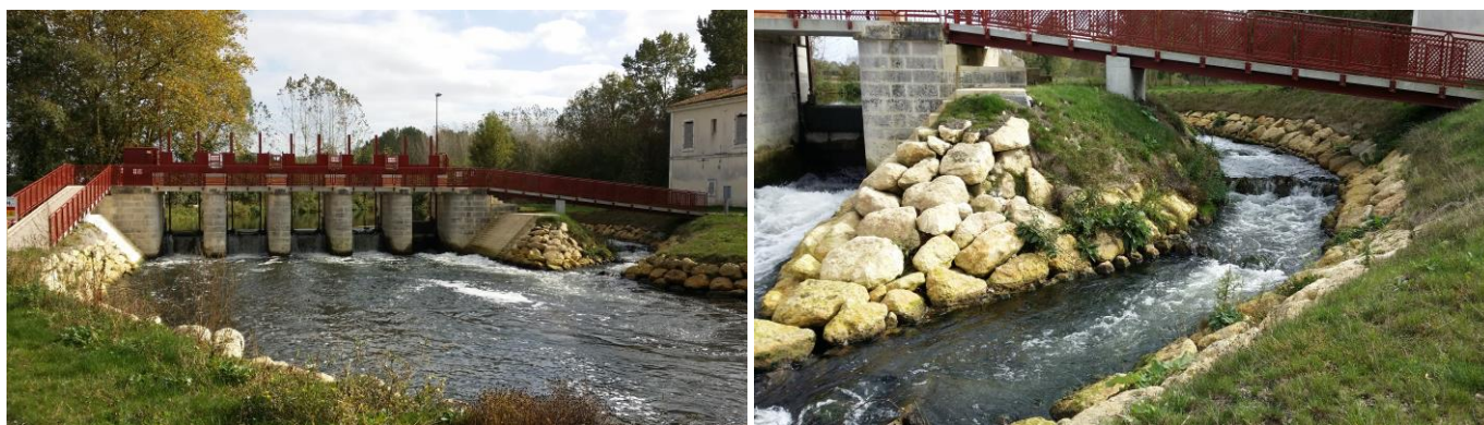
Barrage de l'Houmée et son bras de contournement
