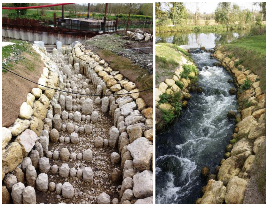
Aménagement du bras de contournement pendant et après travaux
