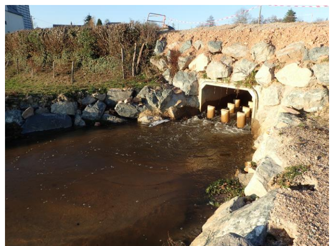
Rampe à macro-rugosités sous pont cadre de la RD291
