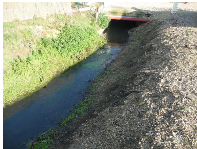
Photographie de l'état initial
